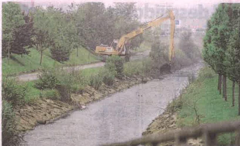
Una excavadora, trabajando en la limpieza del cauce del anillo navegable en 2007. :: PURIFICACIÓN CITOUA
