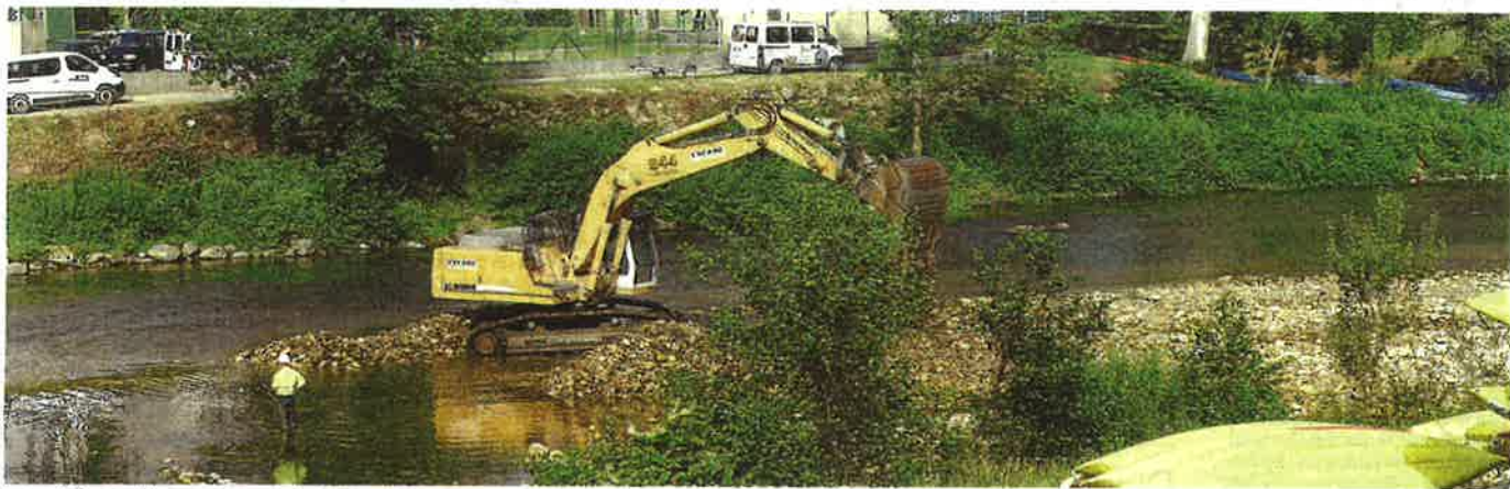
Las máquinas retiran los cantos rodados y la maleza del río en la zona cercana a la salida del Sella. :: NEL ACEBAL
