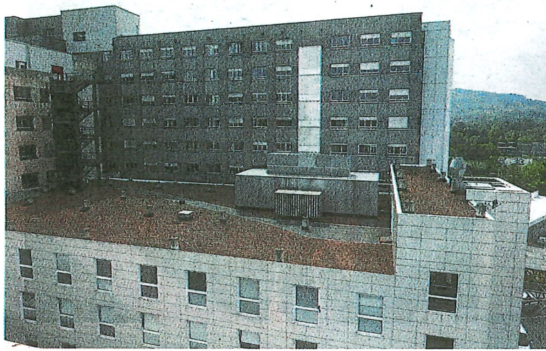
En primer término, el edificio de gerencia y actual acceso principal al Hospital Universitario de Cabueñes, cuya altura se incrementará en dos plantas. Al fondo (en gris), el edificio de hospitalización. PABLO NOSTI
