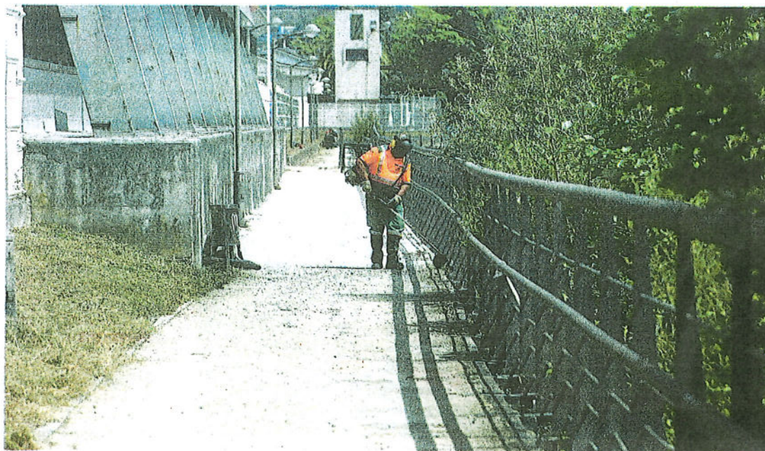
Un operario municipal realizando ayer labores de desbroce en el tramo de senda fluvial del Piles reparado que reabrirá mañana. PALOMA UCHA
