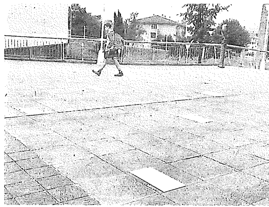
Placas ya instaladas, ayer, en la zona de entrada al Palacio de los Deportes de Gijón. | Fernando Rodríguez
