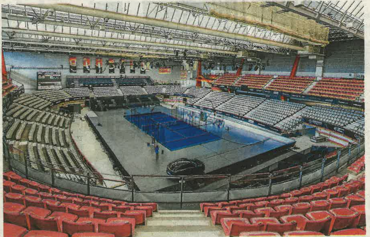
Operarios trabajan ayer en la pista central del Gijón Premier Padel. ARNALDO GARCÍA
